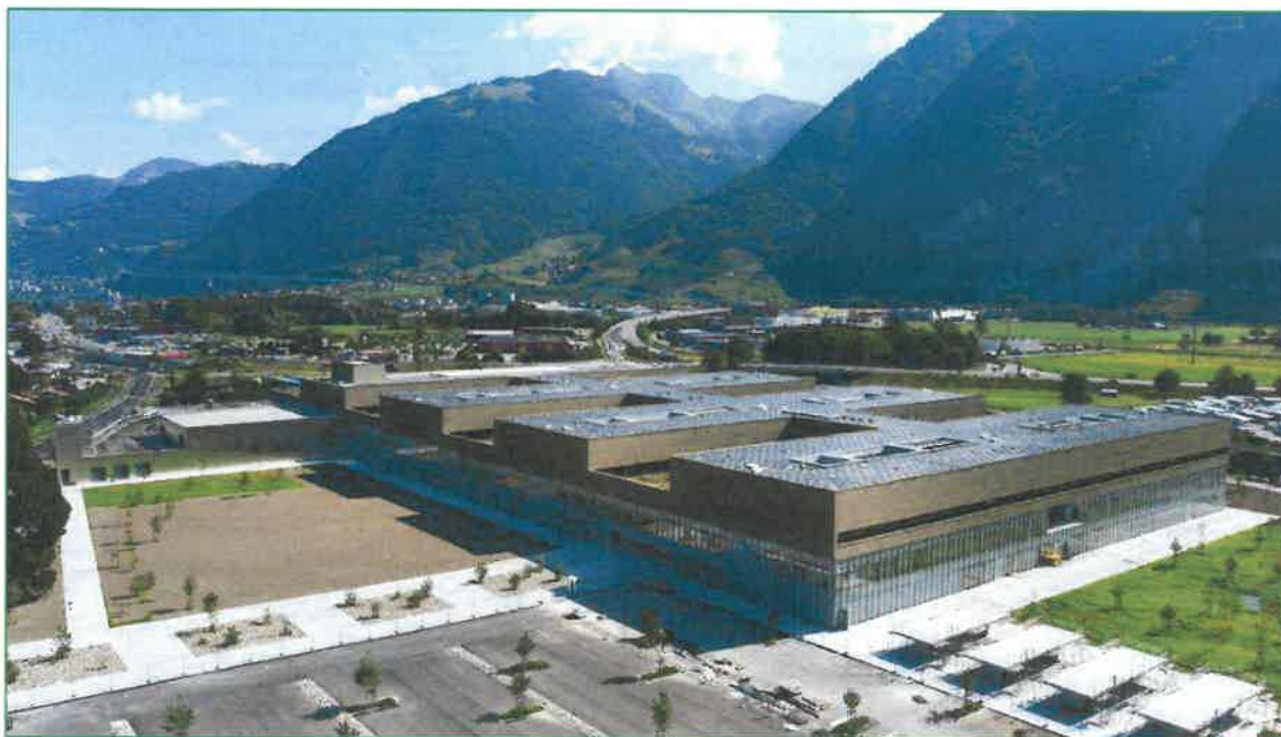
Fig.03 – Hôpital Riviera-Chablais Vaud-Valais
